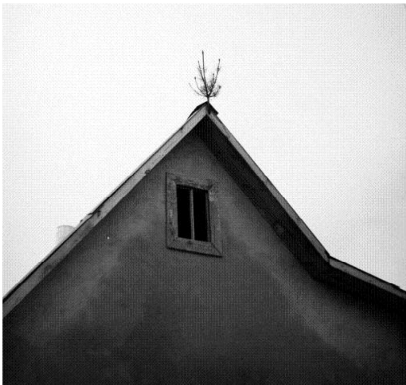
Іл. 3. Обрядове будівельне деревце (“фоінка”) на новобудові, с. Сновидовичі Рокитнівського р-ну Рівенської обл. Світлина автора, 2004 р.
