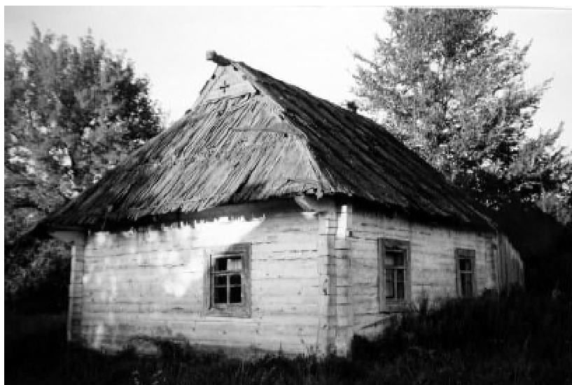
Іл. 4. “Вільчик” на даху поліської хати кінця XIX – початку XX ст., с. Будки Сновидовицькі Рокитнівського р-ну Рівенської обл. Світлина автора, 2004 р.
