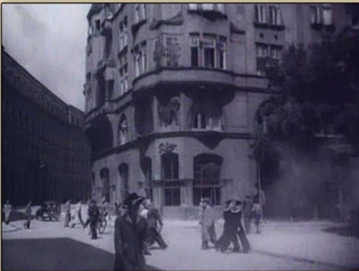
утковий будинок М.Рогатина, в якому розміщувалось кілька банкових установ.
